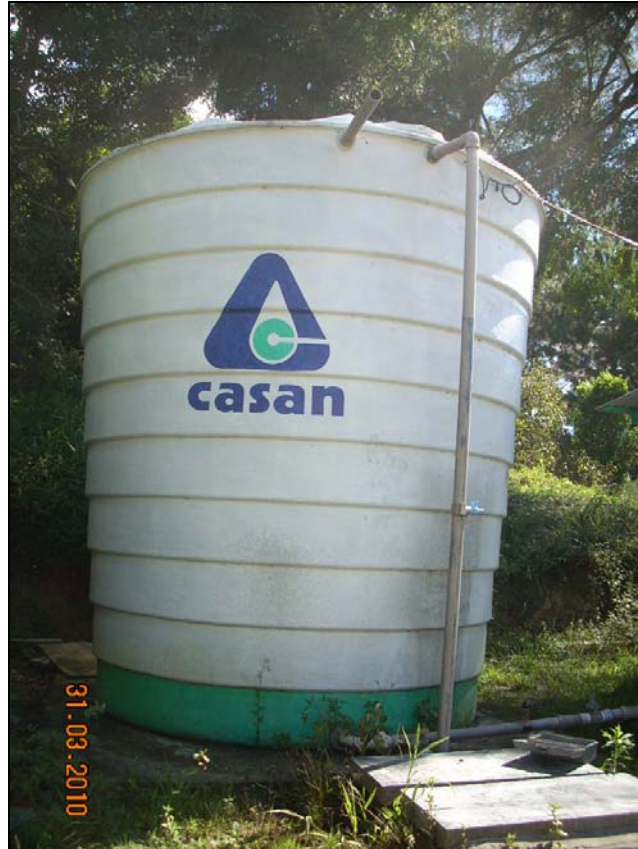
Figura 17– Reservatório R5 - Sistema Craveiro
