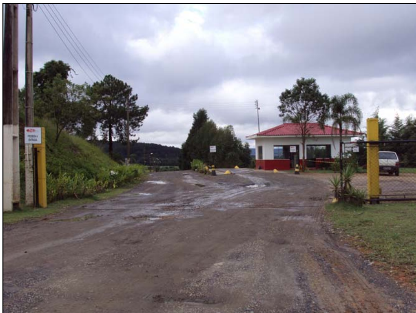
Figura 21 – Portão de acesso ao aterro
