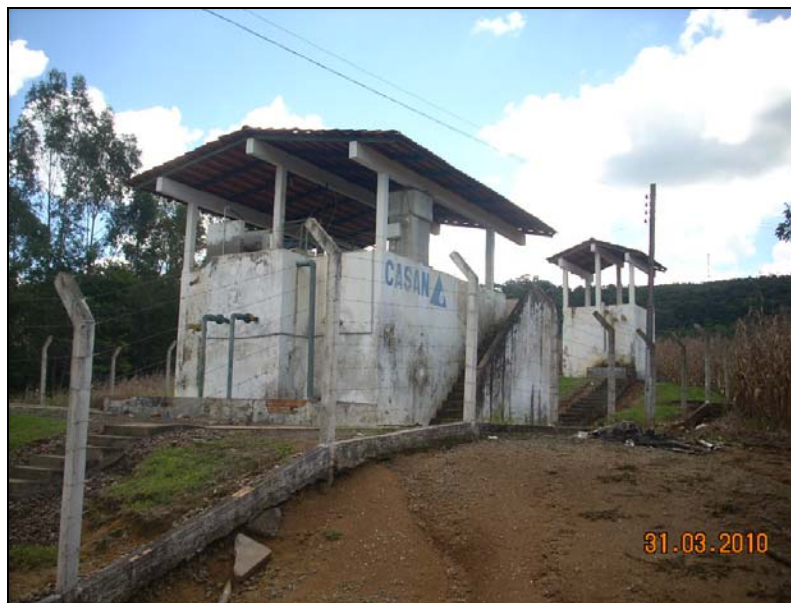
Figura 8 – Vista da ETA do Sistema Santa Terezinha
