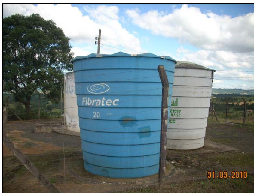
Figura 9- Reservatórios R1, R2 e R3
